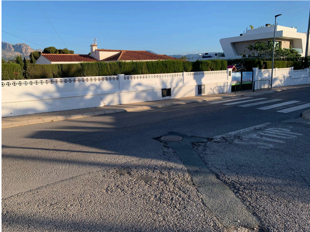
Fotografía 1. Intersección calle Orio con Avenida Sant Marc
