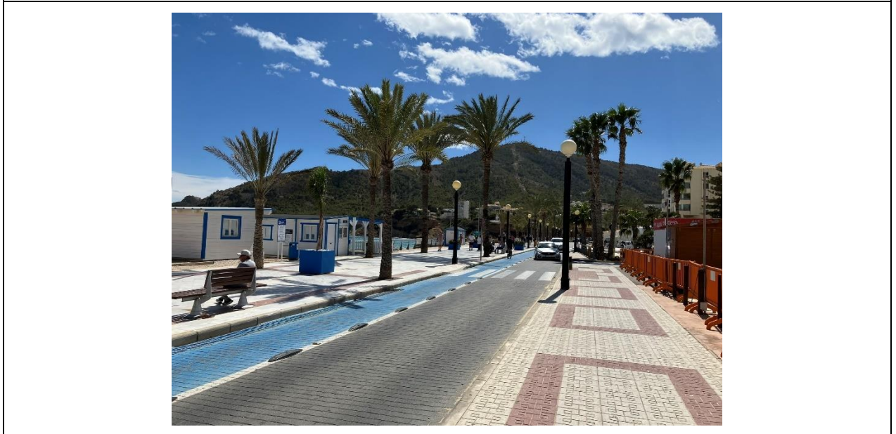
Foto 2.- Disposición tipo del alumbrado a lo largo del paseo.
