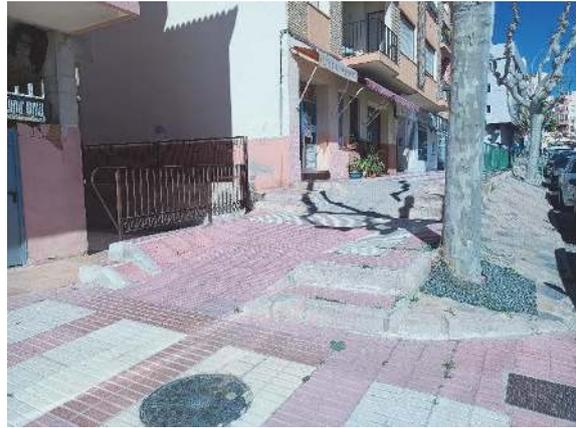
Imagen 4.- Rampas de comunicación entre los distintos niveles que muestra la acera en la intersección de la calle Ferreria con la calle Riu Algar.
