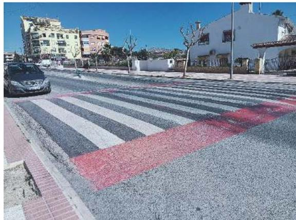
Imagen 8.- Paso de peatones sobreelevado situado en la calle Ferreria, para el que se proyecta su fresado completo como actuación previa al refuerzo del pavimento.
